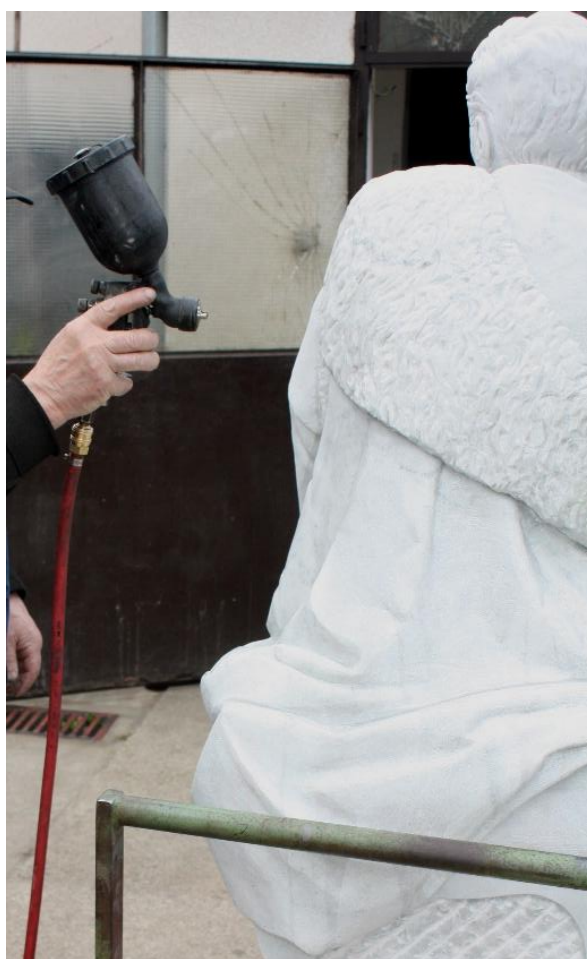
55. kép: Tensid AGS 3550 anti-graffiti réteg felhordása
