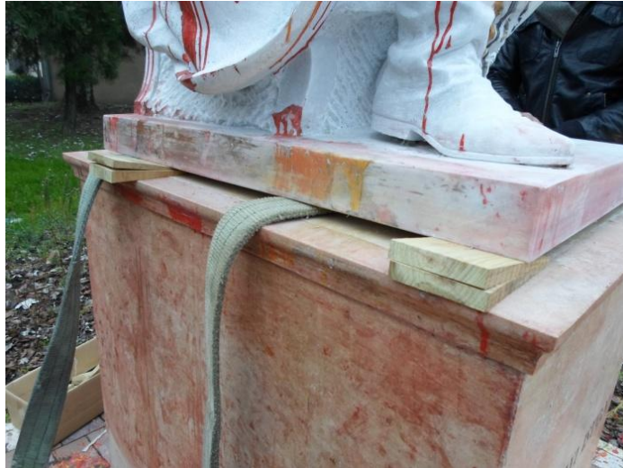
44. kép: A szobor elválasztása a talapzattól
