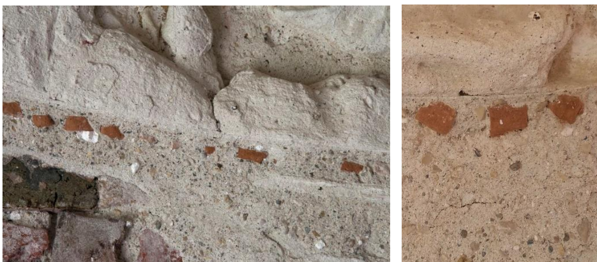
49-49. kép. A sérült körbefutó párkány alatt megfigyelhető alapvakolat, melybe tégladarabokat helyeztek
