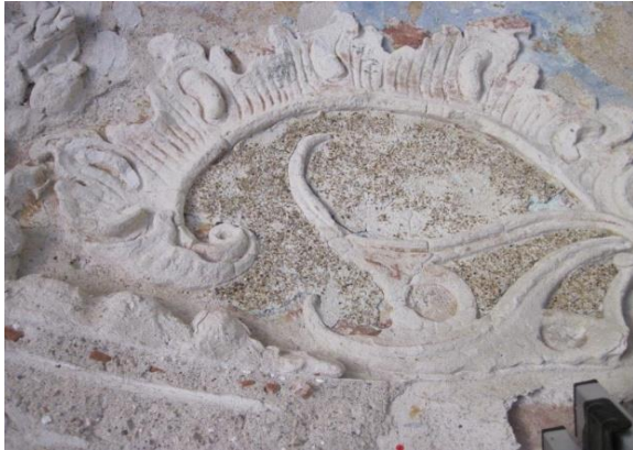
43. kép. Az aprókavicsos díszítések beágyazó vakolatát nem illesztették, simították egyenletesen a keretező stukkókhoz
