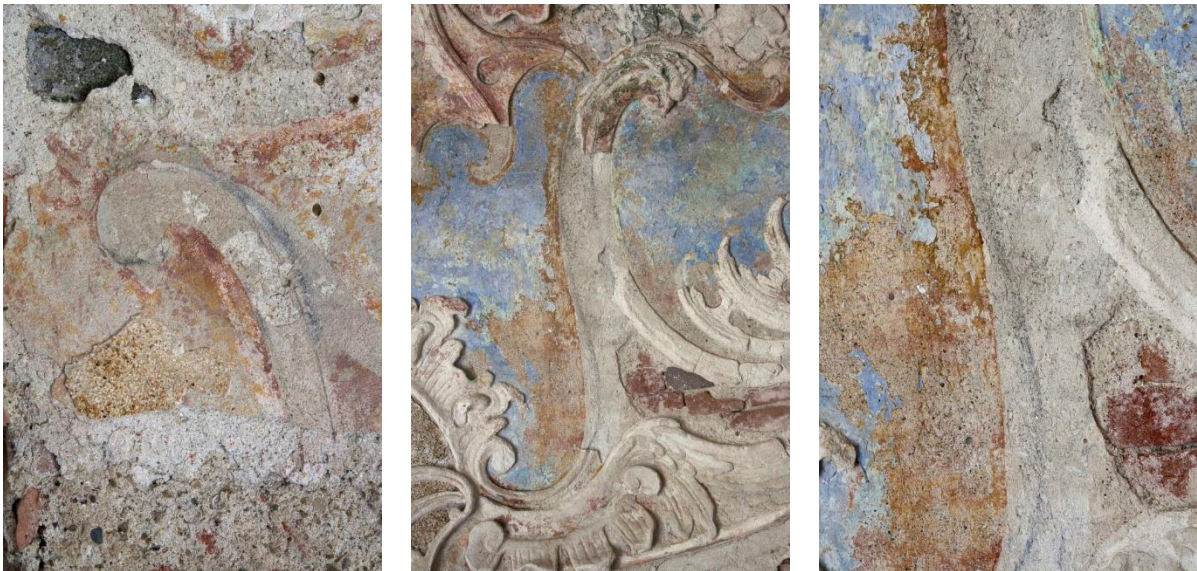
36-37-38. kép. A sérült stukkók alatt megjelenő, fekete növényi szénnel készült alárajzok és pentimentók
