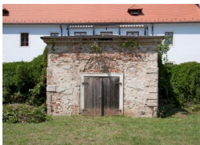
26. kép. Az erősen sérült „grottakápolna” 2015-ben. A homlokzati díszítések nagyrészt elpusztultak
