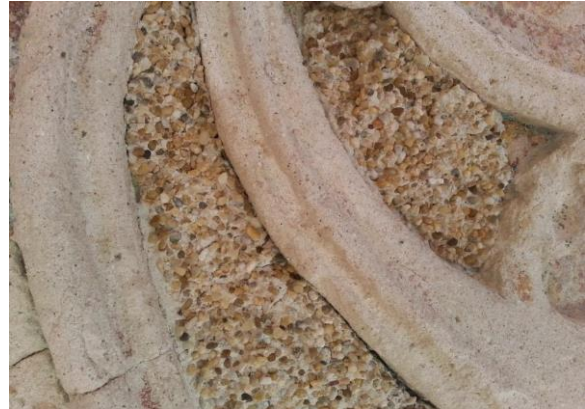
44. kép. A stukkók közötti falfelületnél vékonyan felvitt, még nedves állapotú vakolatba mosott, osztályozott, apró, nagyrészt sárgás árnyalatú kavicsokat nyomkodtak
