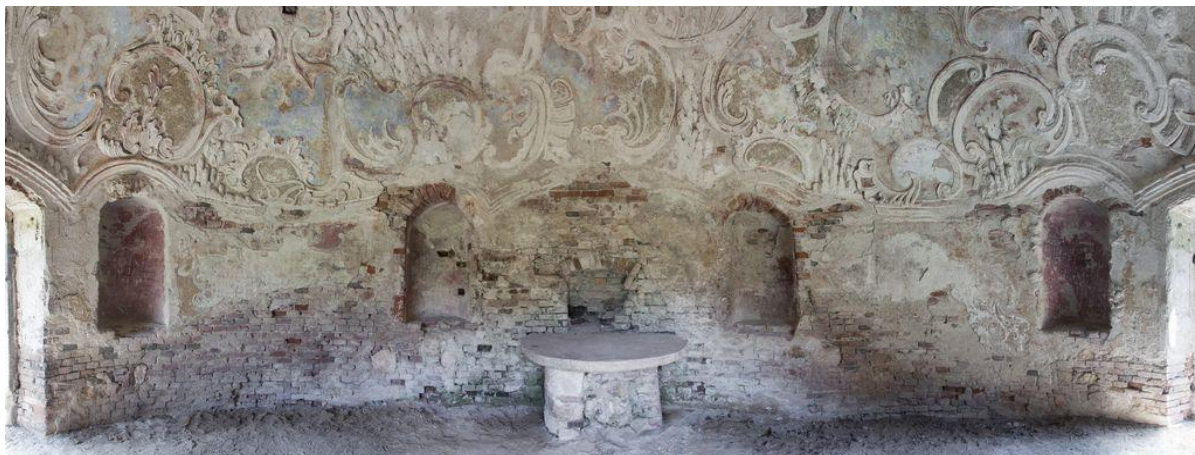
29. kép. A nagymértékben sérült „grottakápolna” belső teréről készült panoráma felvétel 2015-ben
