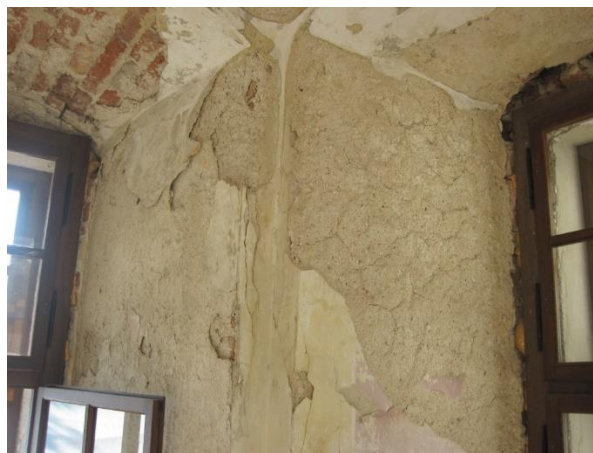
15. kép. A falfestményeket hordozó vakolat réteges elválása volt tapasztalható 2016-ban
