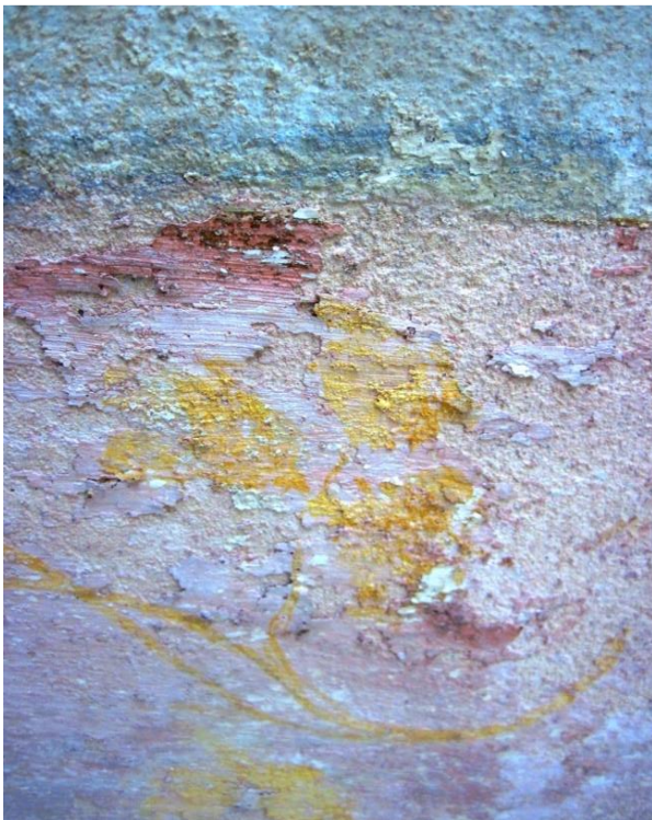
9. kép. Sókárosodások, pergő festékrétegek
