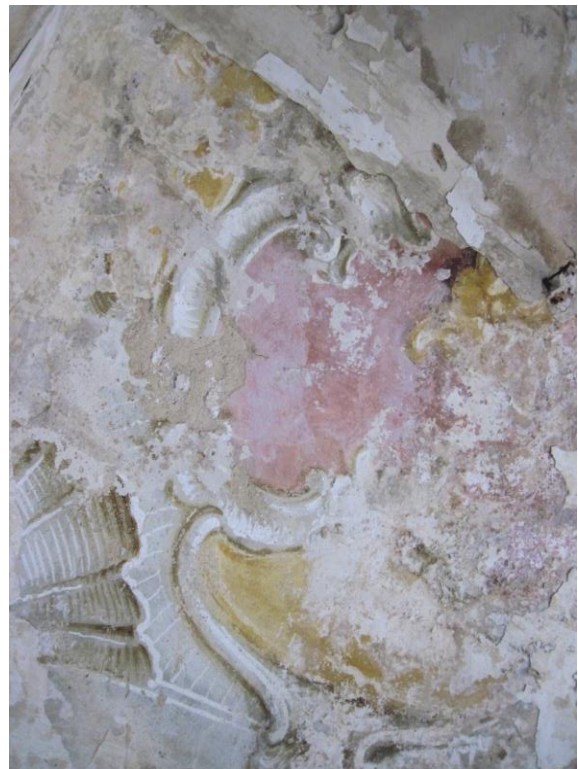
8. kép. Elválások, sókárosodások a festett felületen
