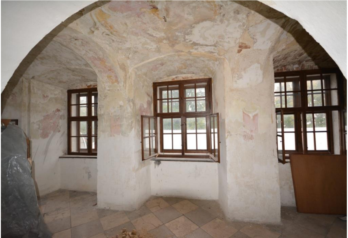
5. kép. A sala terrena belső enteriőrje a falakat beborító ornamentikafestéssel, 2016-ban. A falfestményt ekkor még részben meszelésrétegek fedték.
