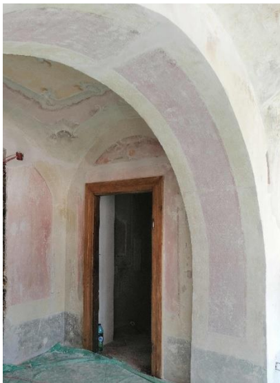
133. kép. A sala terrena teréből nyíló helyiség bejárata
