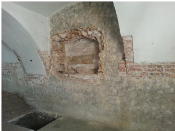
46-47. kép. 17.-18. századi egykori külső homlokzat felületképzése, 1.25-ös számú sarokszoba déli fala
