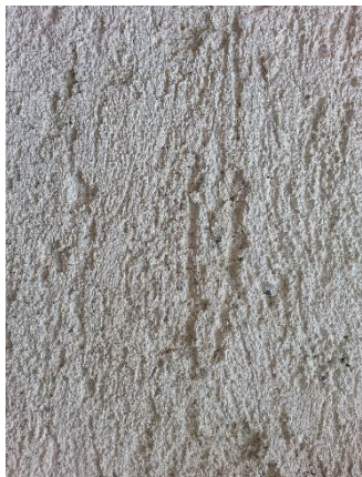
16. kép. Simítóeszköz nyomai a 2. vakolatrétegen
