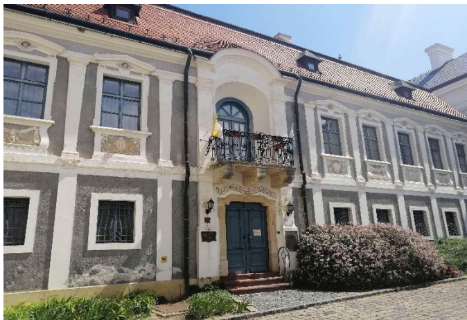
62-63. kép. Veszprém, Nagyréposti palota faszenes homlokzatzvakolata
