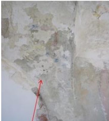
64. kép. Kék festések alatti szürke réteg, Sümeg, püspöki palota sala terrena
