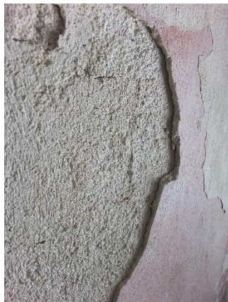
17. kép. A simító- és festővakolat felületi egyenetlensége jól látható sűrű-fényes megvilágításban
