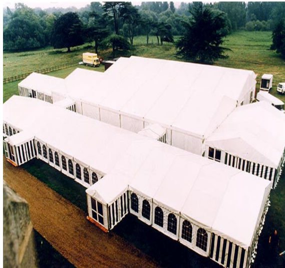
21. ábra: rendezvényszervezés, átmeneti épületek (forrás: www.marqueesolutions.co.uk )
