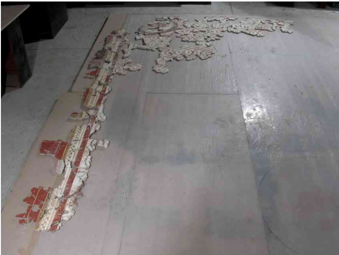
Az összeillesztett stukkópárkány imitációhossza 386 cm
