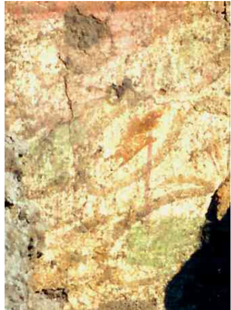
Lábazaton látható függőleges csurgás
