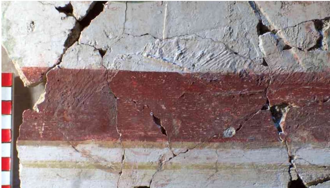
Az oldalfal besimító rétege ráfed a mennyezet intonacojára
