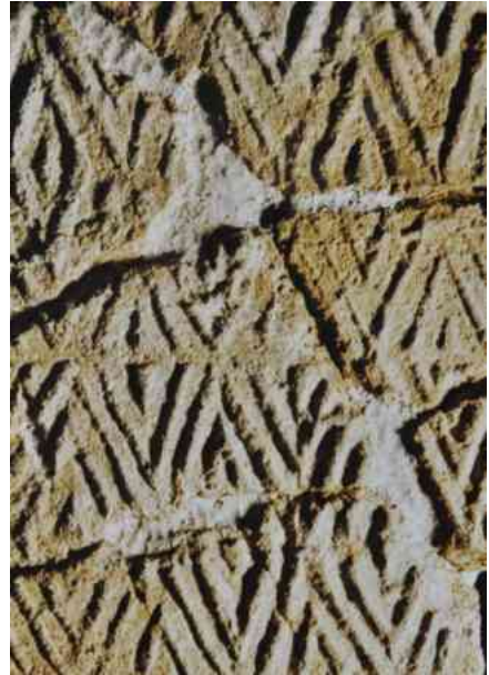
Hátoldal statikai célú tömítése
