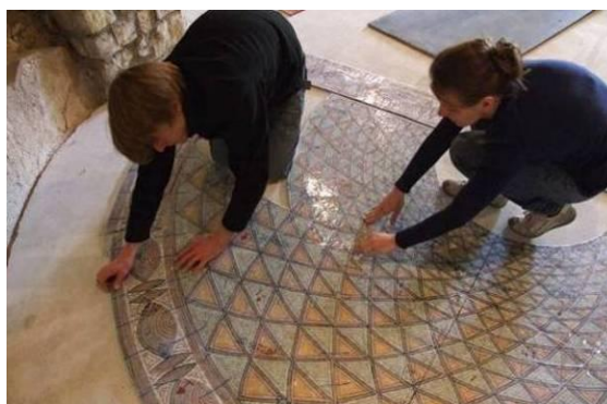
81-90. kép Az apszis mozaik beépítésének munkálatai; az apszis elemei a műteremben, a motívum összeillesztése a helyszínen szárazon, a központi madaras motívum beépítése, és egyéb helyszíni munkálatok.
