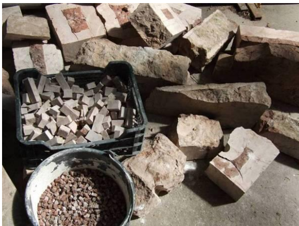
47-50. kép A kőanyag feldolgozása és előkészítése a rakáshoz.
