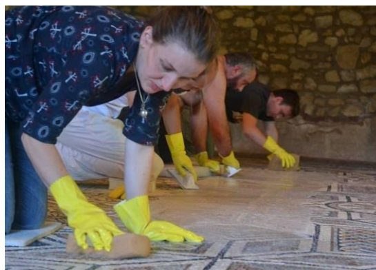
92. kép A kész felület fugázása.
