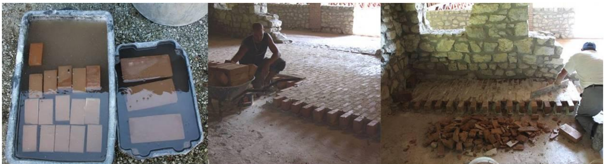
69-71. kép Az új vízszintes aljzat készítésének fázisai.
