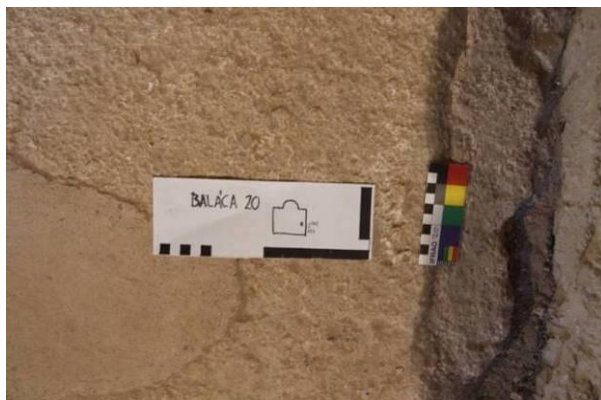
41-42. kép A fehér beágyazóhabarcs (supranucleus) maradványa, a terem északi falának alsó harmadánál.
