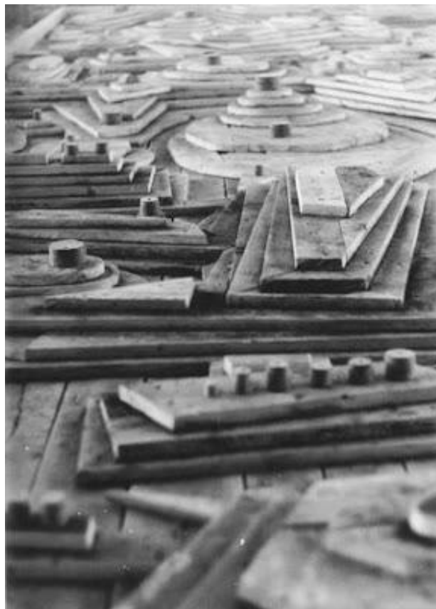
48. kép Az Alagút betonzsaluzatáról készült kép forrás: https://amerigotot.blogspot.com/2009/06/mar-latom-az-alagut-veget.html Nemes Péter, 2009.
