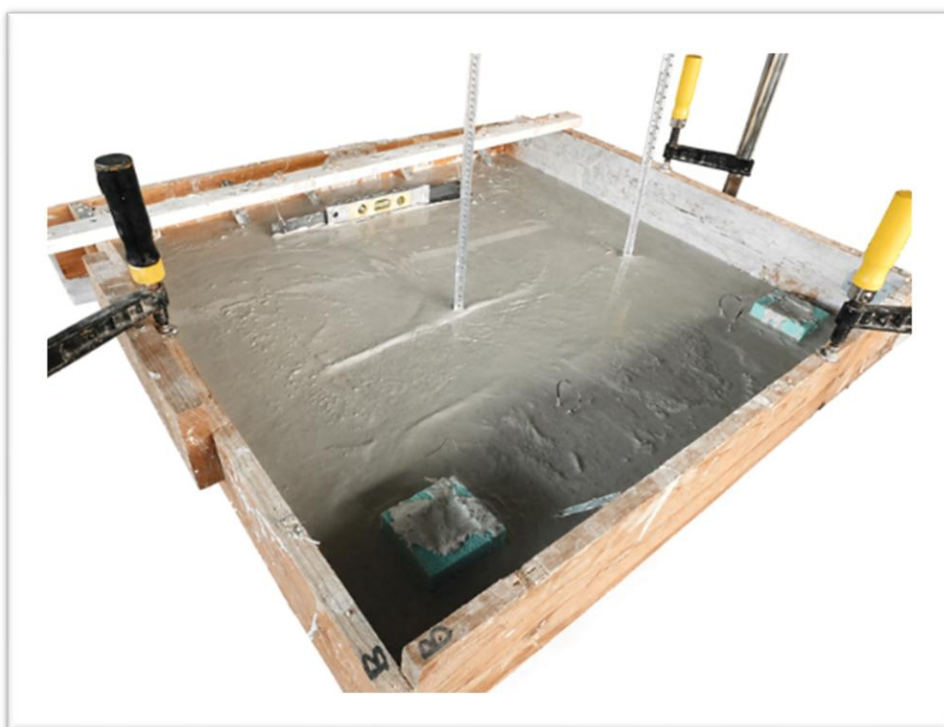
64. kép A beton beöntését követő állapota zsaluzatba. forrás: Saját fotó, 2025.
