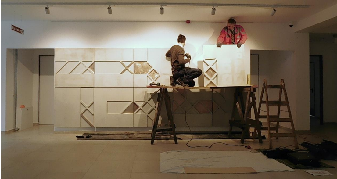
65. kép Az elkészült beton-bronz panelek felszerelése a főiskola aulájának falára. forrás: Saját fotó, 2026.
