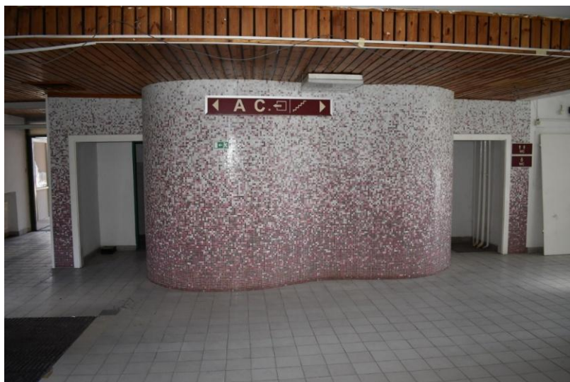
Az EJF B épület aula falán Klossy Irén tervezet mozaikfal forrás: Kecskés Nóra, EJF, 2023.08.
