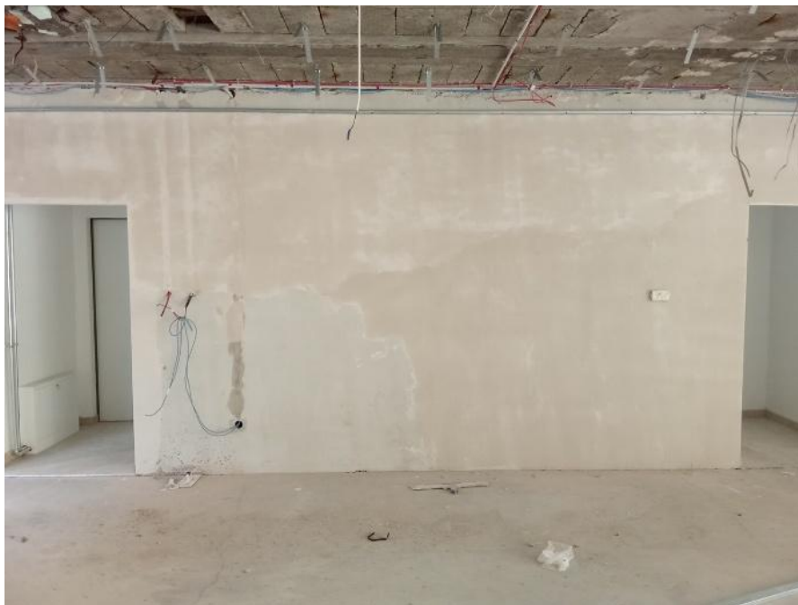
Az aula főfala az átalakítás közben forrás. saját fotó, 2025.
