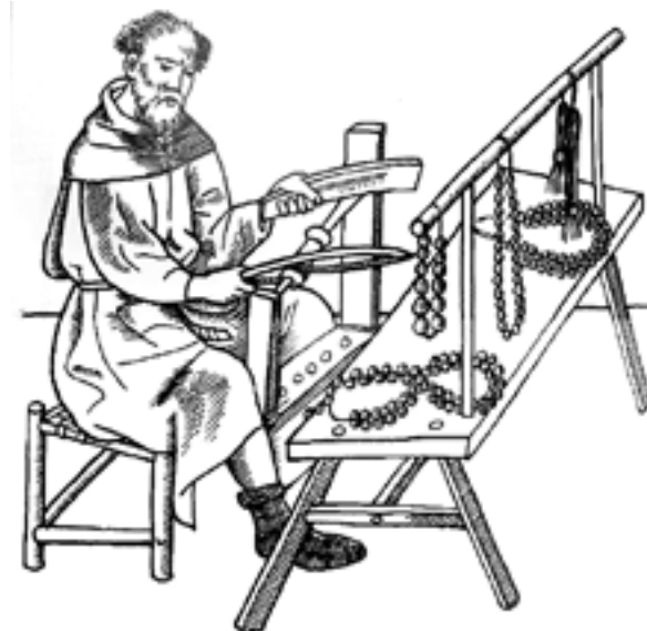
37. ábra: Középkori rózsafüzér-készítő. Feltételezhető, hogy a két befogó közül az egyik szabadon mozgó. A gyöngyfúró meghajtása íjjal történik (15. század)
