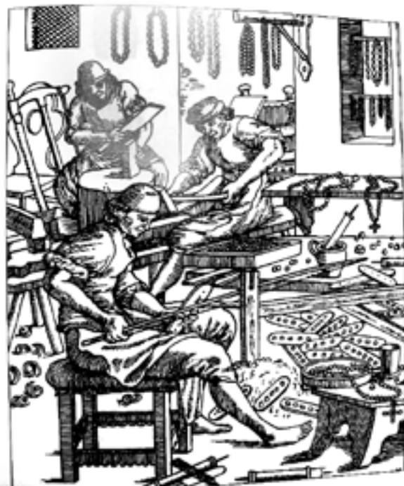
36. ábra: Középkori rózsafüzér-készítő műhely. Az új fúró tengelyének egyik befogója egy rögzített lécszár, a másik maga a megfúrandó munkadarab
